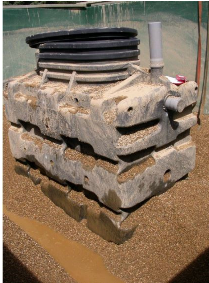
Prova di pozzo
